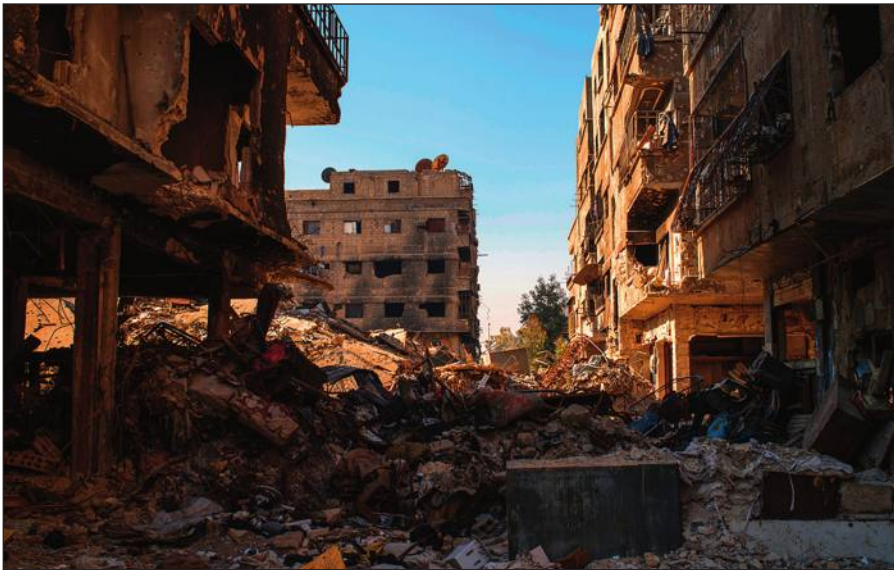
Разрушенный боевиками ИГИЛ Дамаск.
